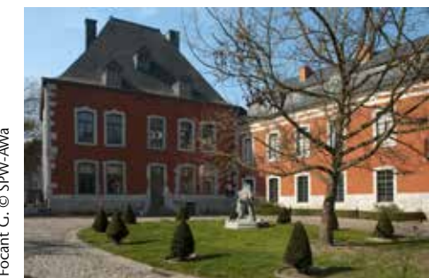
Marche-en-Famenne. Maison Jadot, façade arrière et vue du parc.
