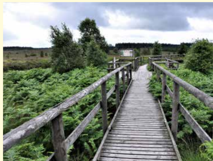
Les caillebotis : des ouvrages d'art par-dessus les tourbières du haut plateau.
