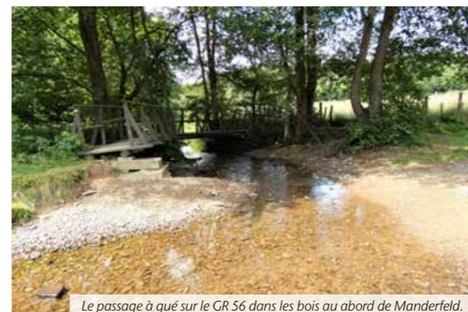
Le passage à gué sur le GR 56 dans les bois au bord de Manderfeld.
