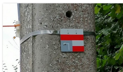
FIGURE 2.16 – Cerclage sur poteau
