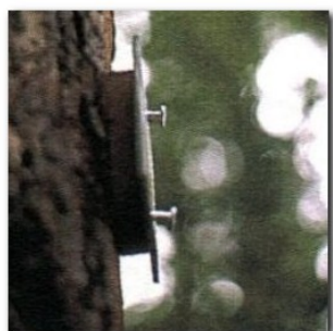
FIGURE 2.15 – Laisser les clous dépasser
