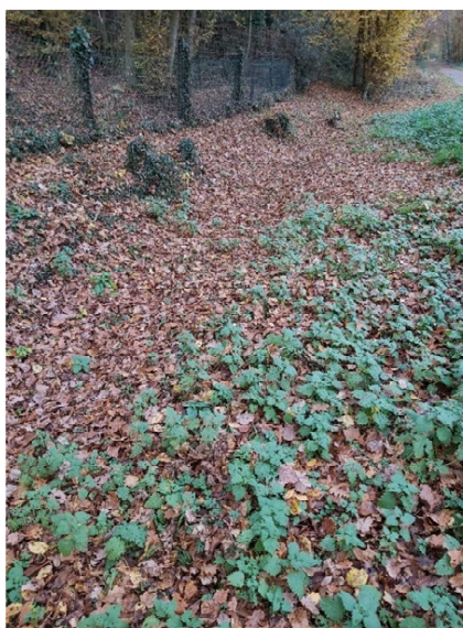
Figure 4 : Fossé rempli de feuilles (35 cm)
